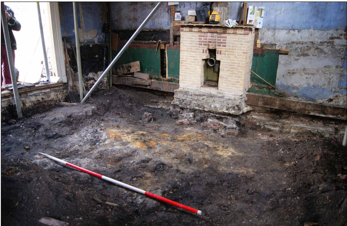
Afb. 8 De sporen aan de noordzijde van het pand.
