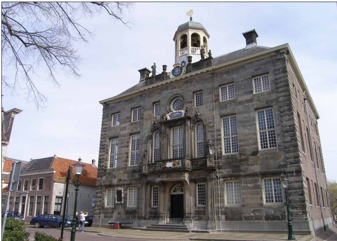
Afb. 4 Het stadhuis van Enkhuizen aan de Breedstraat.
